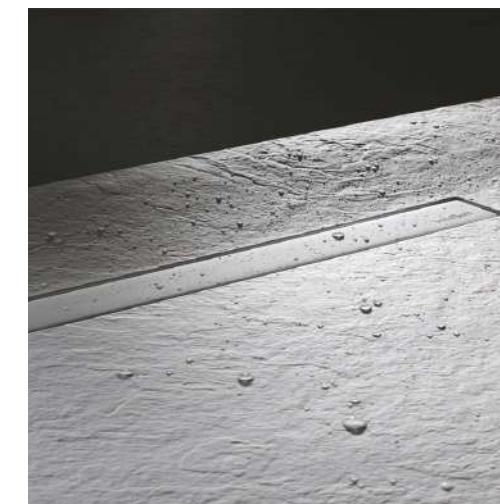
SolidSoft põrandakate ja trapp
